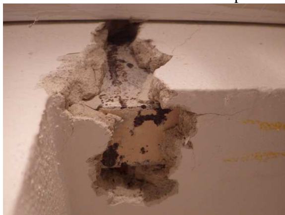
Foto č. 21- V2-detail umístění výztuže
