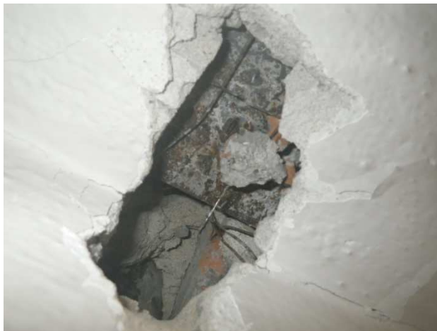
Foto č. 24-25 vypraskání omítek a fabionu .....
