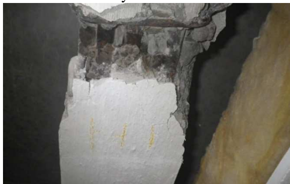
Foto č.12- NV3-vyztužení trámku ..... Foto č. 13- NV2-ověření ŽB desky
