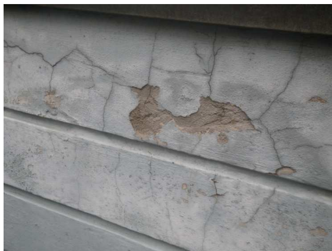
Foto č. 47--50- poškození rampy vlhkostí, poškození omítek a soklu
