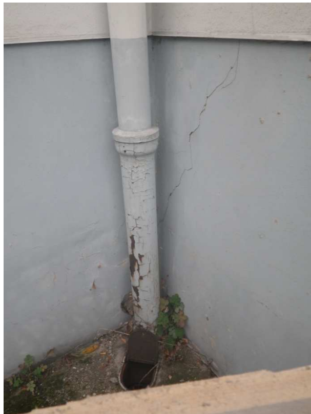
Foto č. 63- Šikmá trhлина-statická porucha
