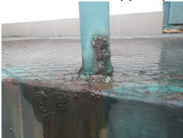
Foto č. 62- poškození soklu -dvorní strana
