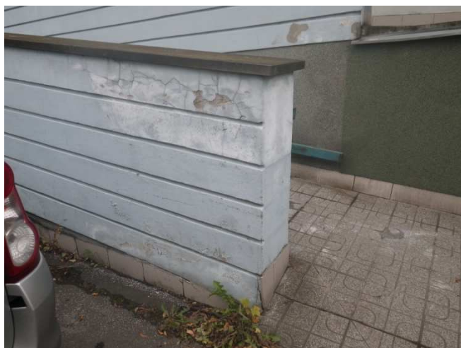
Foto č. 47--50- poškození rampy vlhkostí, poškození omítek a soklu
