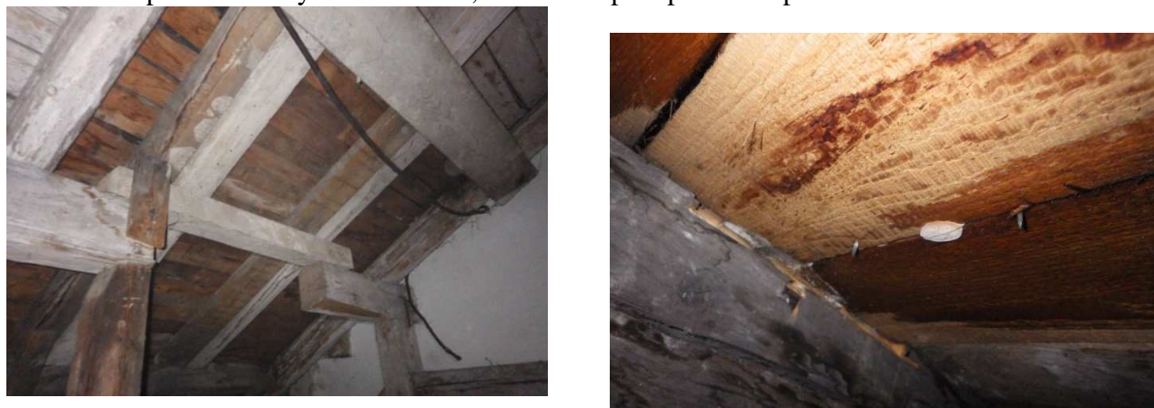
Foto č. 72 - výskyt plodnice dřevokazných hub, napadení krokve a bednění,
