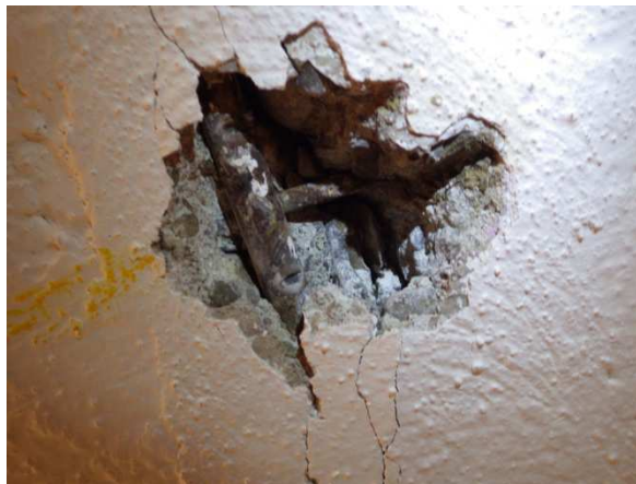
Foto č. 8- NV2-celkový pohled ..... Foto č. 9- NV2-detail – pásnice I nosníku
