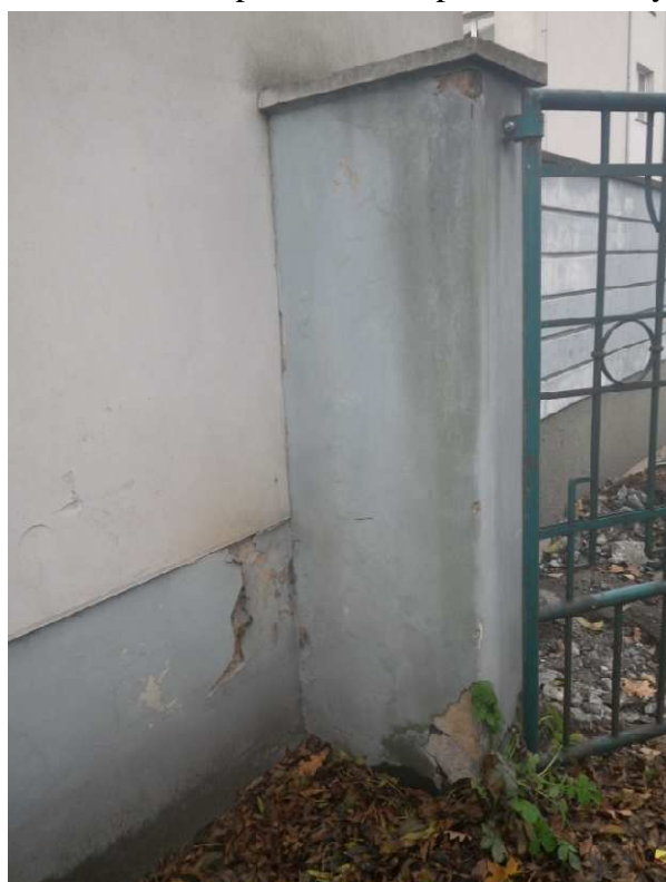
Foto č. 56-57- poškozené a zpuchřelé omítky
