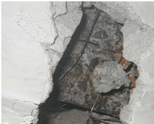
Foto č. 24-25 vypraskání omítek a fabionu .....
