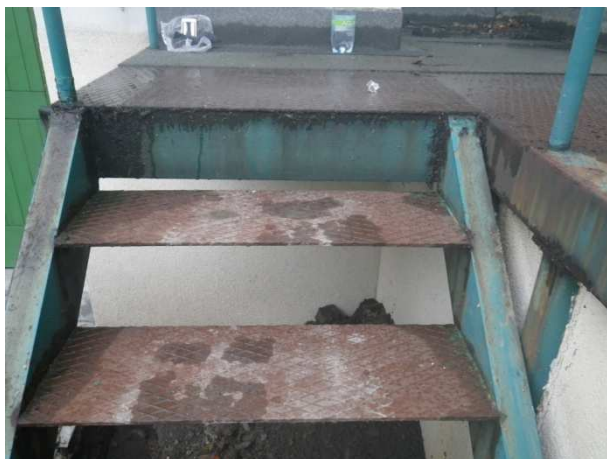
Foto č. 60- detail koroze v napojení sloupku
