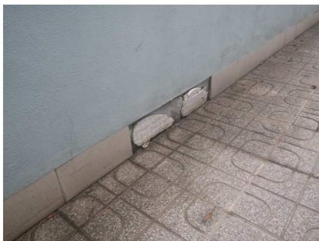
Foto č. 55- projevy vlhkosti na rampě
