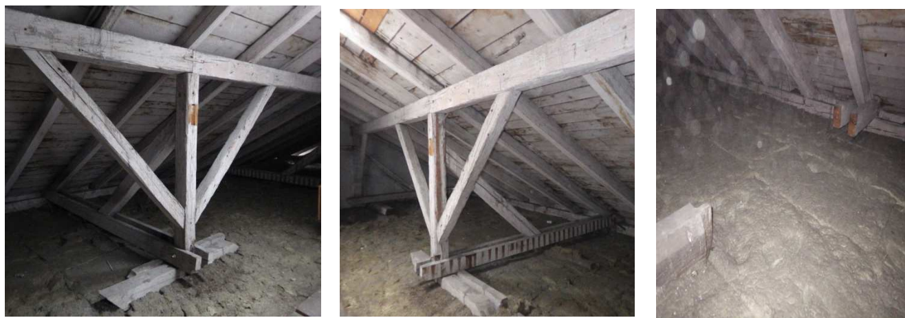
Foto č. 71- přerušení a výměna vaznice, dodatečné podepření sloupkem
