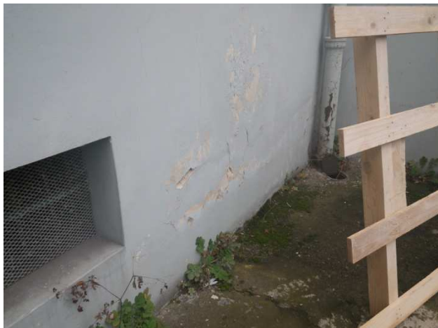
Foto č. 62- poškození soklu -dvorní strana
