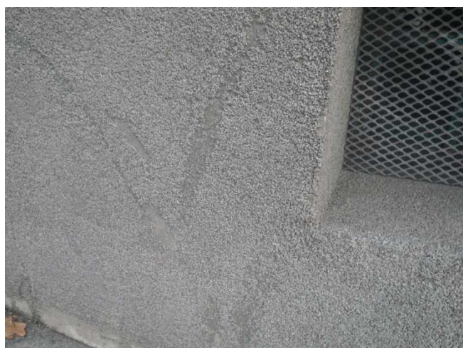
Foto č. 47--50- poškození rampy vlhkostí, poškození omítek a soklu
