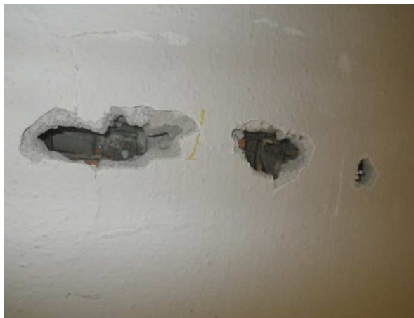
Foto č. 14- NV4-celkový pohled ..... Foto č. 15- NV4- detail spodní pásnice I nosníku
