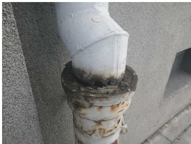
Foto č. 44- svod-degradace materiálu
