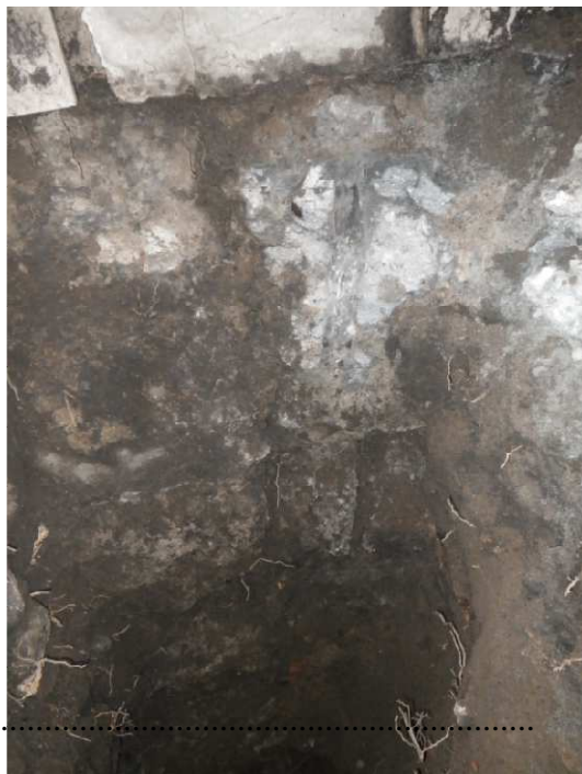
Foto č. 4- K 1 –detail skladba – betony
