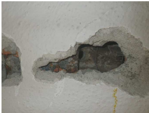
Foto č. 14- NV4-celkový pohled ..... Foto č. 15- NV4- detail spodní pásnice I nosníku
