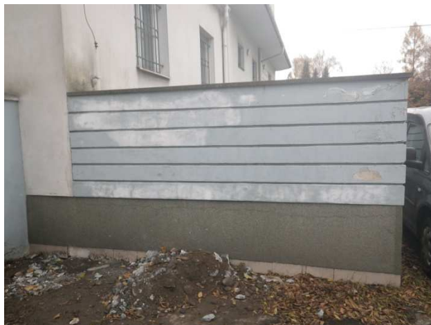
Foto č. 55- projevy vlhkosti na rampě
