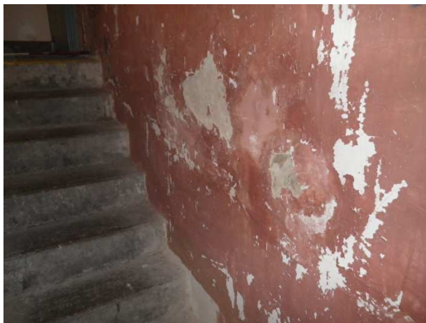
Foto č. 29-30- poškozené omítky vlivem vlhkostí .....
