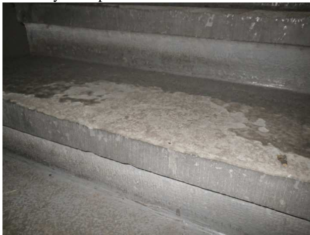
Foto č. 28- šikmá trhlina ve schodišťovém prostoru mezi 1.NP/1.PP
