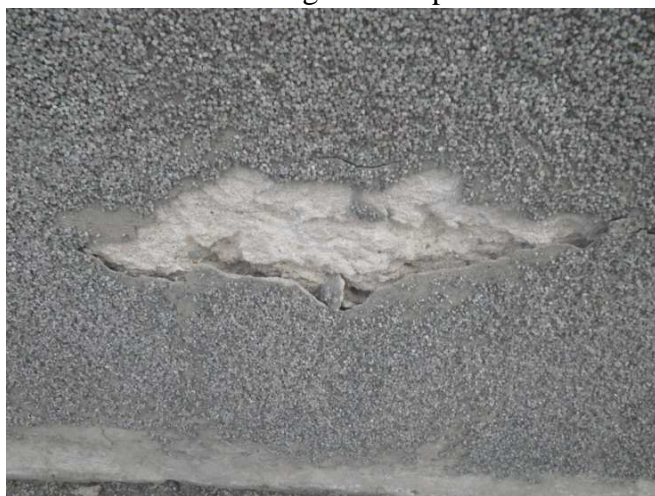
Foto č. 47--50- poškození rampy vlhkostí, poškození omítek a soklu
