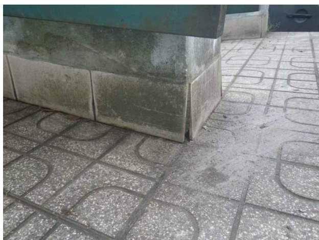
Foto č. 56-57- poškozené a zpuchřelé omítky
