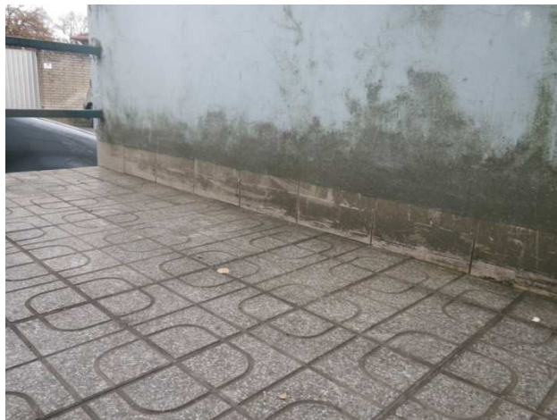
Foto č. 53-54- poškození soklu v lokalitě rampy, výskyt řas
