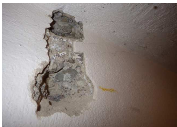
Foto č. 21- V2-detail umístění výztuže
