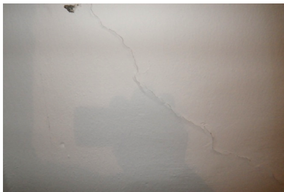
Foto č. 28- šikmá trhlina ve schodišťovém prostoru mezi 1.NP/1.PP
